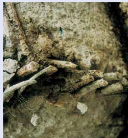
▲ 掘り出された鉄筋コンクリート基礎
