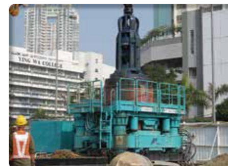
地中障害物切削
