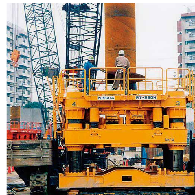
RT-260Hによる鋼管杭施工状況
