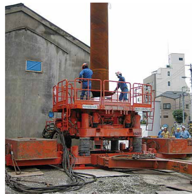
RT-150LIIによる鋼管杭施工状況
