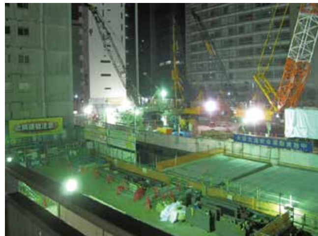
▲RT-320の施工現場全景(大規模再開発工事)
